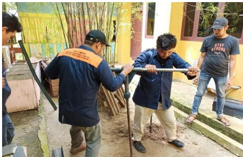
Gambar 5. Pelaksanaan Pengujian Auger Boring
