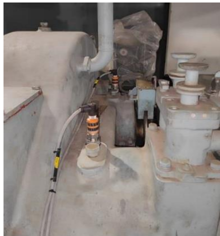
Gambar 4 Pemasangan Sensor Getaran Pada Turbin
