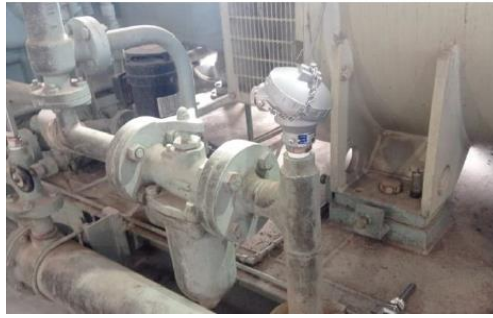
Gambar 3 Pemasangan Sensor Suhu Pada Turbin
