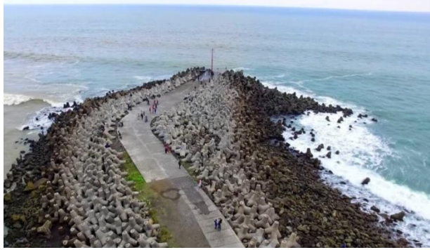
Gambar 5. Pemecah Gelombang di Pantai Glagah, Kulon Progo
