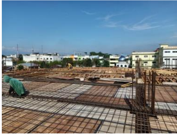
Gambar 13. Pekerjaan Pembesian
