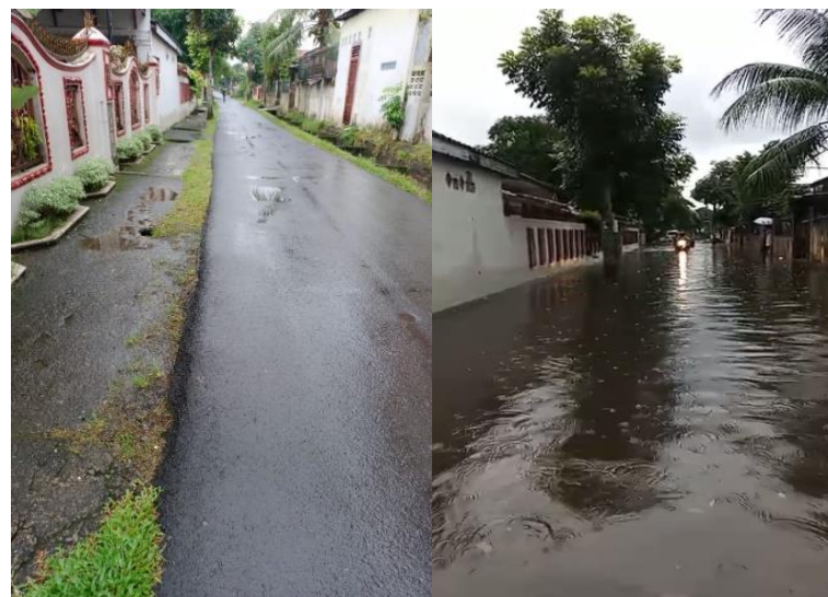
Gambar 4. Eksisting jalan mawar 1
