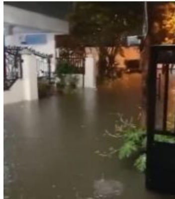
Gambar 7. Kondisi Air Masuk Area Rumah Warga
