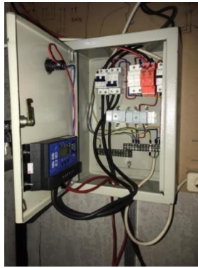
Gambar 13. Semua Komponen Sudah Terinstalasi
