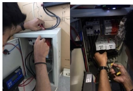
Gambar 12. Pemasangan Instalasi Kabel Di Dalam Panel Box
