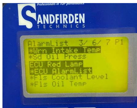
Gambar 5. Alarm ECU Red Lamp Dengan Menunjukkan Fls Coolant Level
