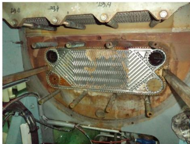
Gambar 3. Kontruksi dari evaporator plate (Sumber : (simbolon firmadi, 2015))
