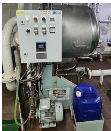
Gambar 5. Fresh water generator di MV CNC Jawa (Sumber: Data pribadi di kapal MV CNC Jawa)
