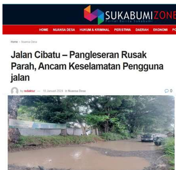
Gambar 1. 1 Kerusakan Ruas Jalan Raya Pangleseran Kabupaten Sukabumi (Sumber: SUKABUMIZONE, 2024)
