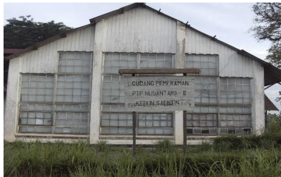
Gambar 2. Tampak Belakang Gudang Pengeraman Tembakau Desa Saentis
