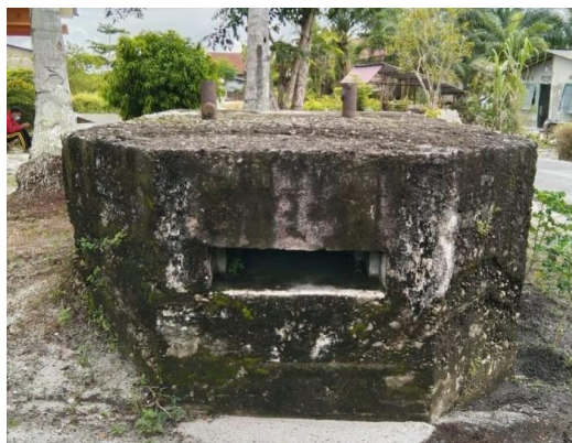
Gambar 1. Bagian Belakang Bunker
