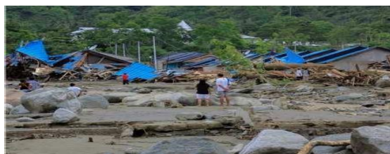
Gambar 2 Area Kerusakan Pasca Bencana
