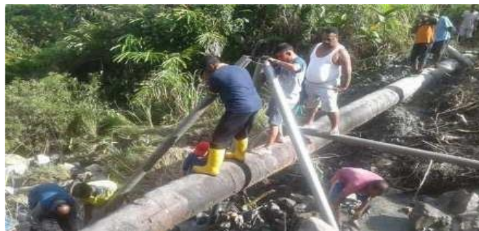
Gambar 5 Perbaikan pipa air utama Kampung Doyo Baru
