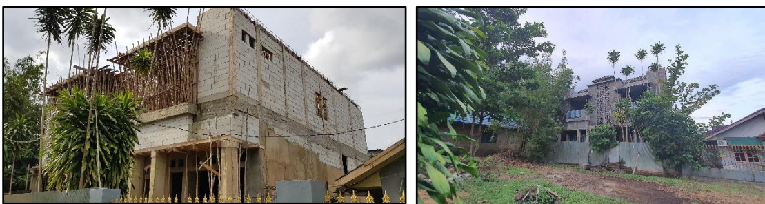
Gambar 6. Dokumentasi pelaksanaan konstruksi bangunan Nani's Town House (kiri atas: foto depan pelaksanaan 40%; sudut kanan atas: foto depan pelaksanaan 70%)
