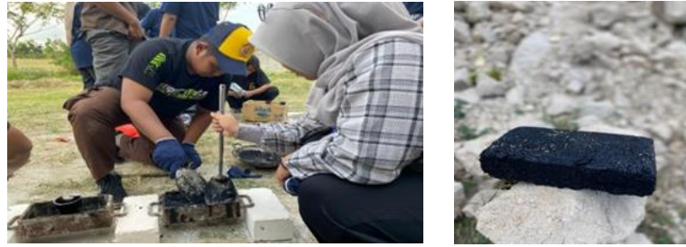
Gambar 4. Pembuatan paving block dari sampah
