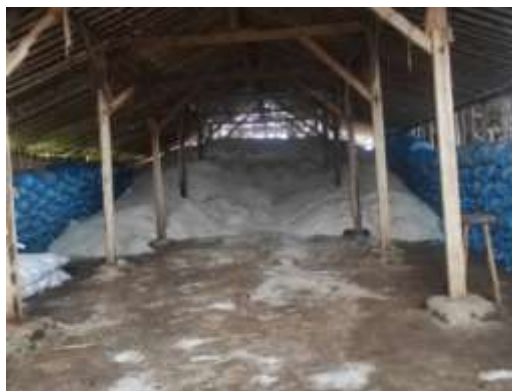
Gambar 9 Kondisi gudang penyimpanan garam dapur di Pati
