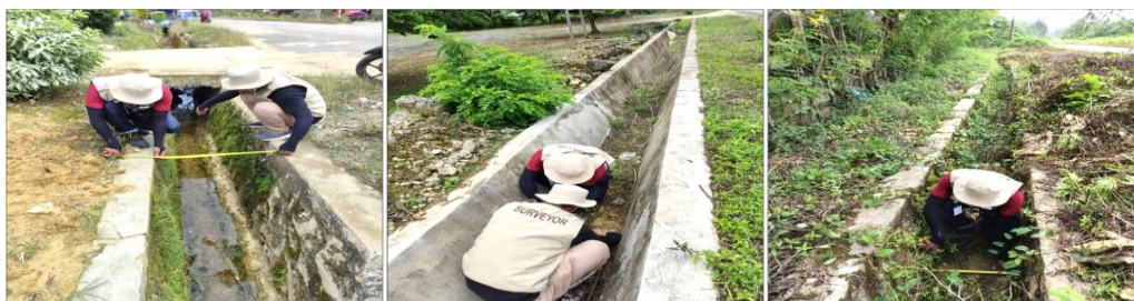
Gambar 2. Bentuk Saluran Drainase di Kab. Konawe Kepulauan Sumber: Hasil Survey Dinas Pekerjaan Umum dan Tata Ruang Kab. Konawe Kepulauan (2023)
