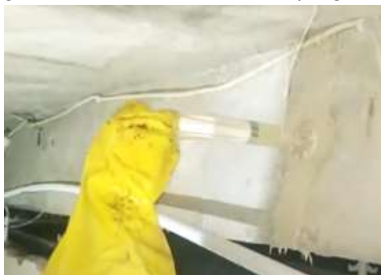
Gambar 9. Injeksi pada bagian yang mengalami keretakan
