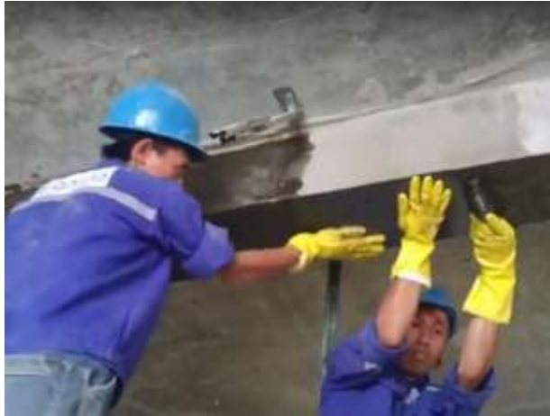
Gambar 14. Pemasangan FRP pada Balok
