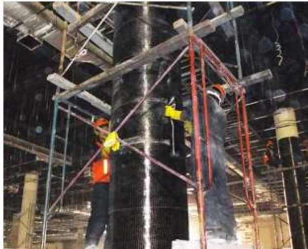
Gambar 5. Perkuatan Struktur dengan FRP
