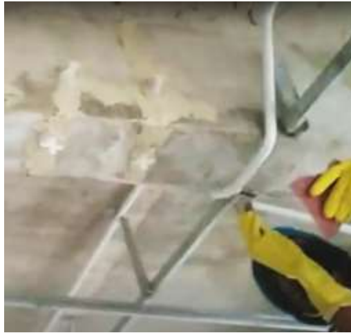
Gambar 8. Penambalan pada bagian yang mengalami keretakan
