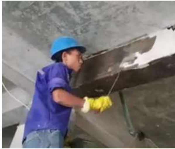
Gambar 12. Pelapisan Epoxy pada Permuakaan Balok
