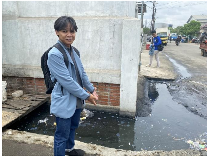
Gambar 4. Drainase Pelabuhan Muara Angke
