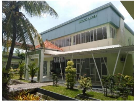
Gambar 1. Kondisi Bangunan Dialysis Center RSUD Negara
