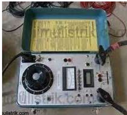
Gambar 4. 3 Pengujian Tahanan Kontak Pada PLTU Buton Adipala
